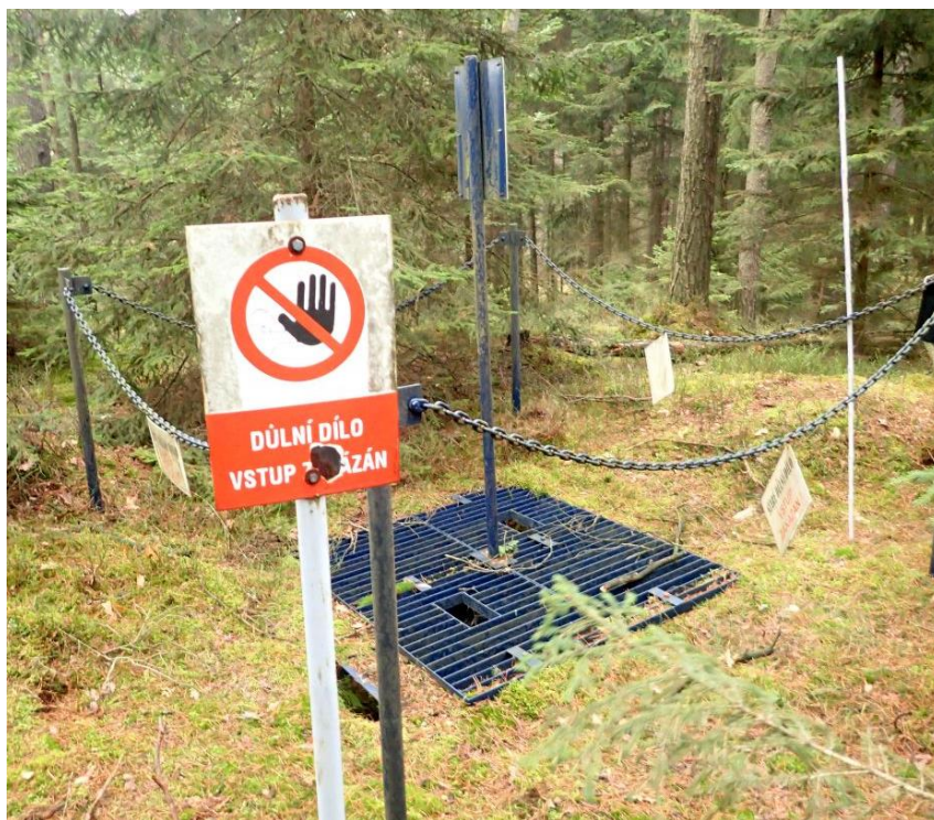
Obrázek č. 60: Zajištění SDD Boreček I (stav v r. 2016)
