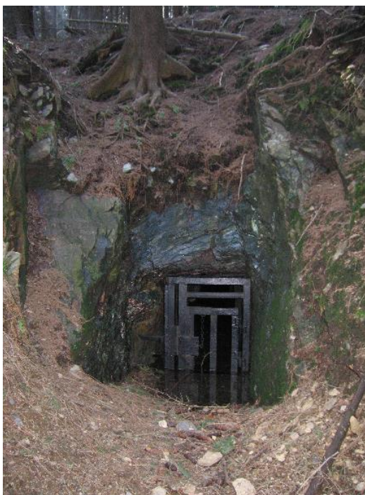
Obrázek č. 64: Zajištěné ústí štoly v revíru Sn rud u Nového Města p. Smrkem (stav IV/2009)
